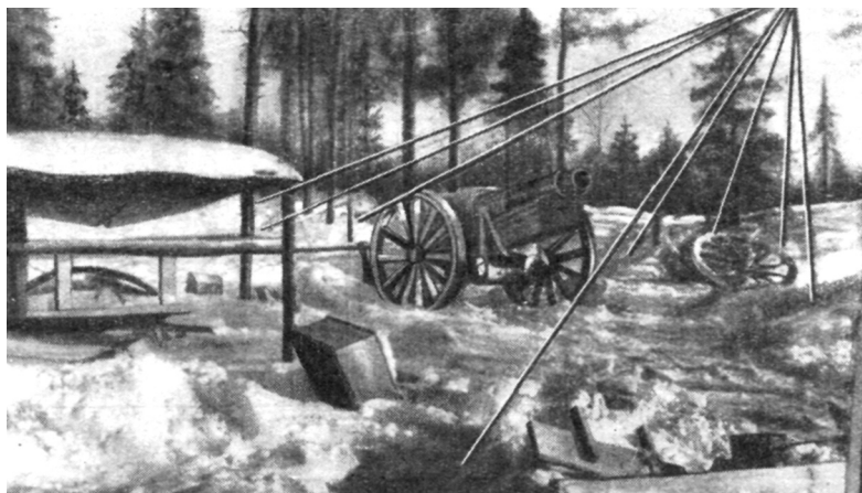
Ил. 4. Остатки уничтоженной финской батареи
