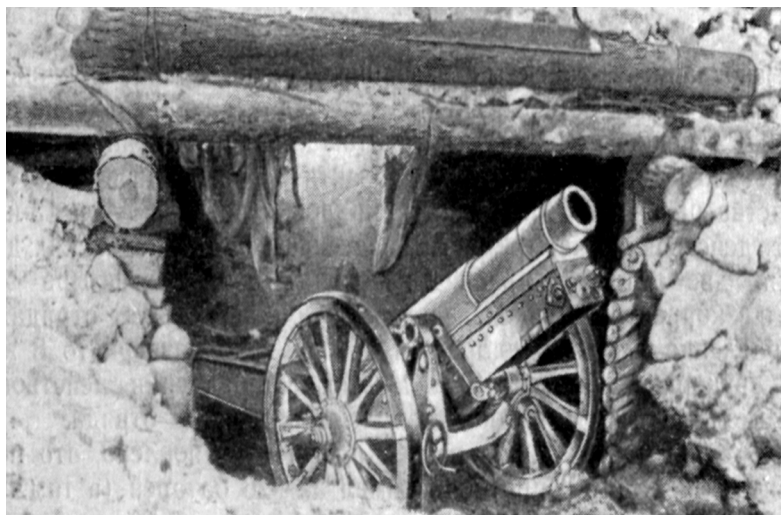
Ил. 1. Финские орудия располагались в окопах с перекрытием в два–три наката
