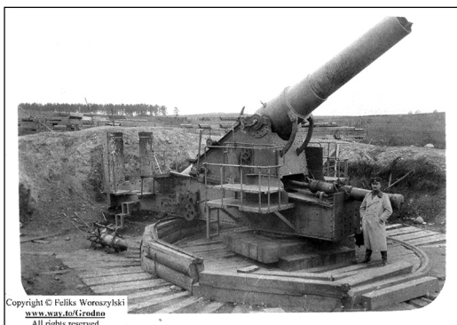
Рис. 4. 10-дм береговое орудие на полевой позиции крепости Гродно. Хорошо видно деревянное основание. Часть ствола оторвана. Снимок был сделан уже после захвата крепости кайзеровской армией. 1915–1916 гг. Открытка из коллекции Ф. Ворошильского
