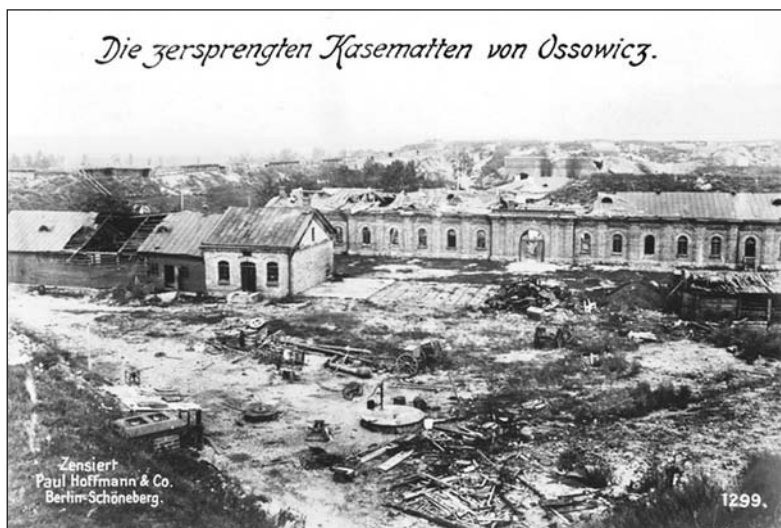
Рис. 4. Крепость Осовец. Разрушенные сооружения форта № I. Германское фото 1916 г.
