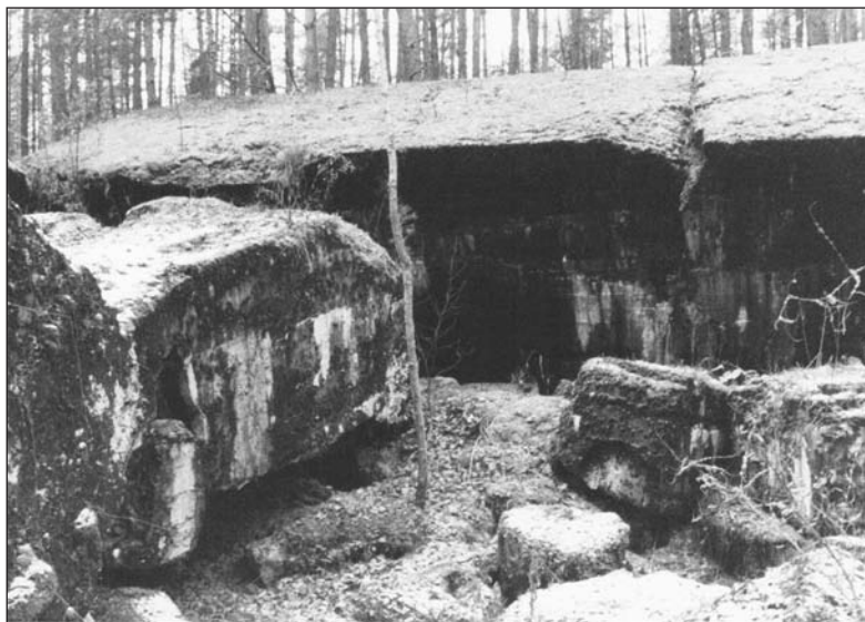
Рис. 6. Крепость Осовец. Форт № IV (Новый), разрушенный пороховой погреб. Современное состояние
