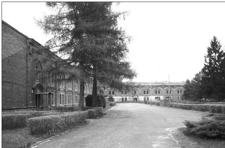
Рис. 2. Крепость Осовец. Форт № I (Центральный), казармы. Современное состояние
